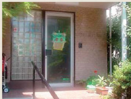
保育室入り口。病院隣接の空き家を改修
